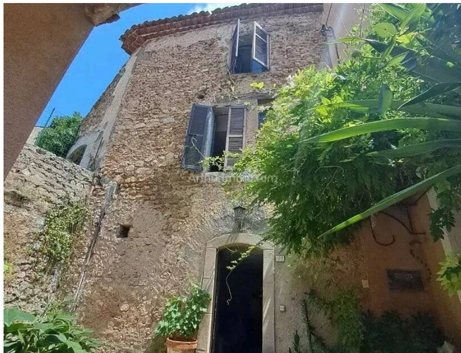
Maison de village à rénover au cœur de Villecroze
